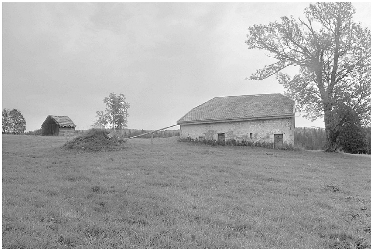
Vue générale, ferme et grenier fort.
