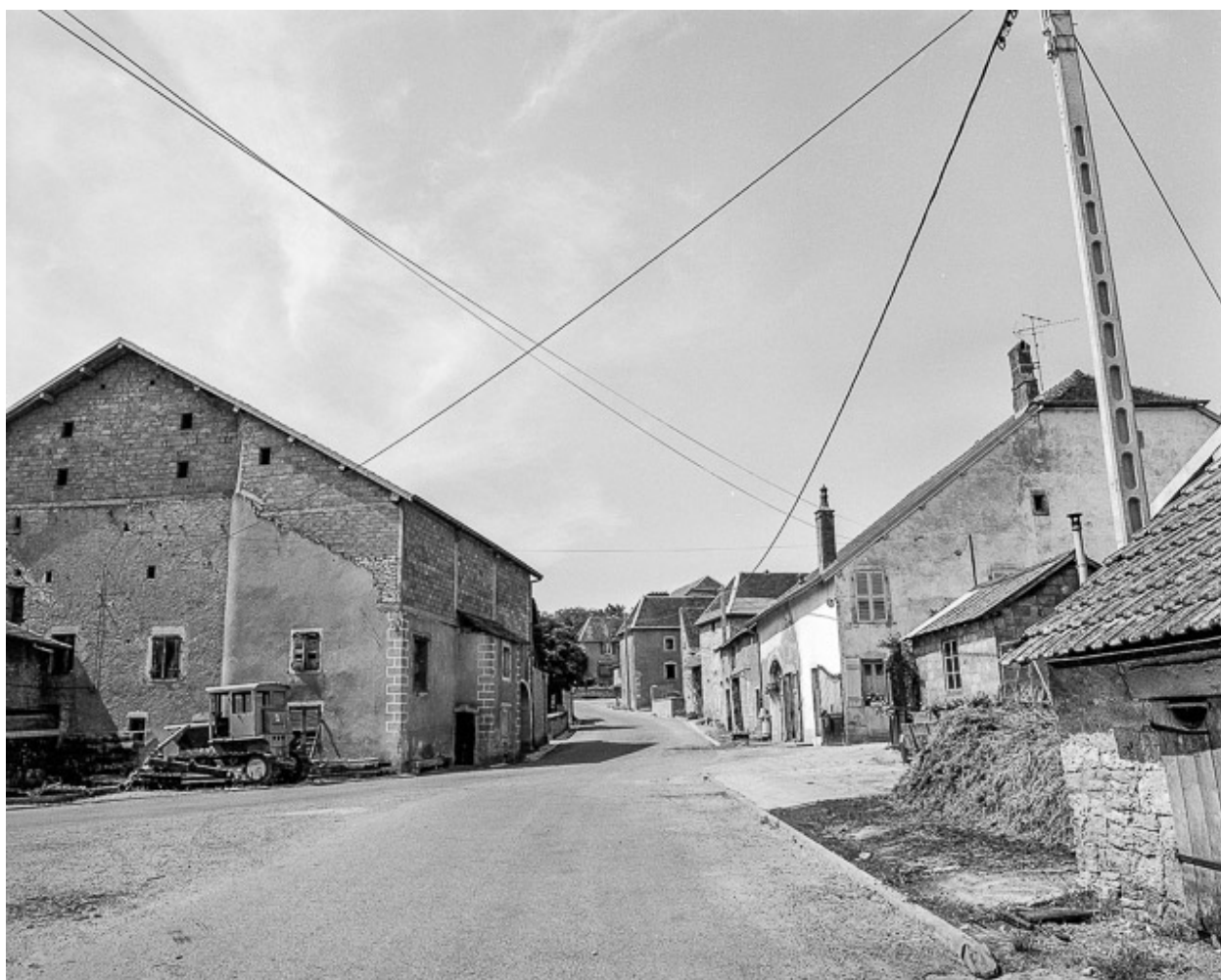
Maison située rue d'Amont à Chenevrey : façade latérale gauche.
