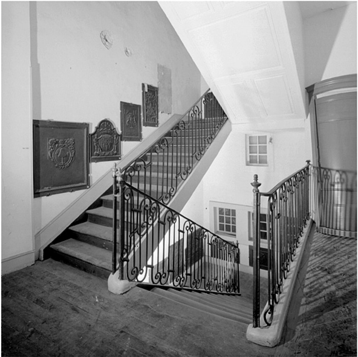
Escalier vu du palier du premier étage.
