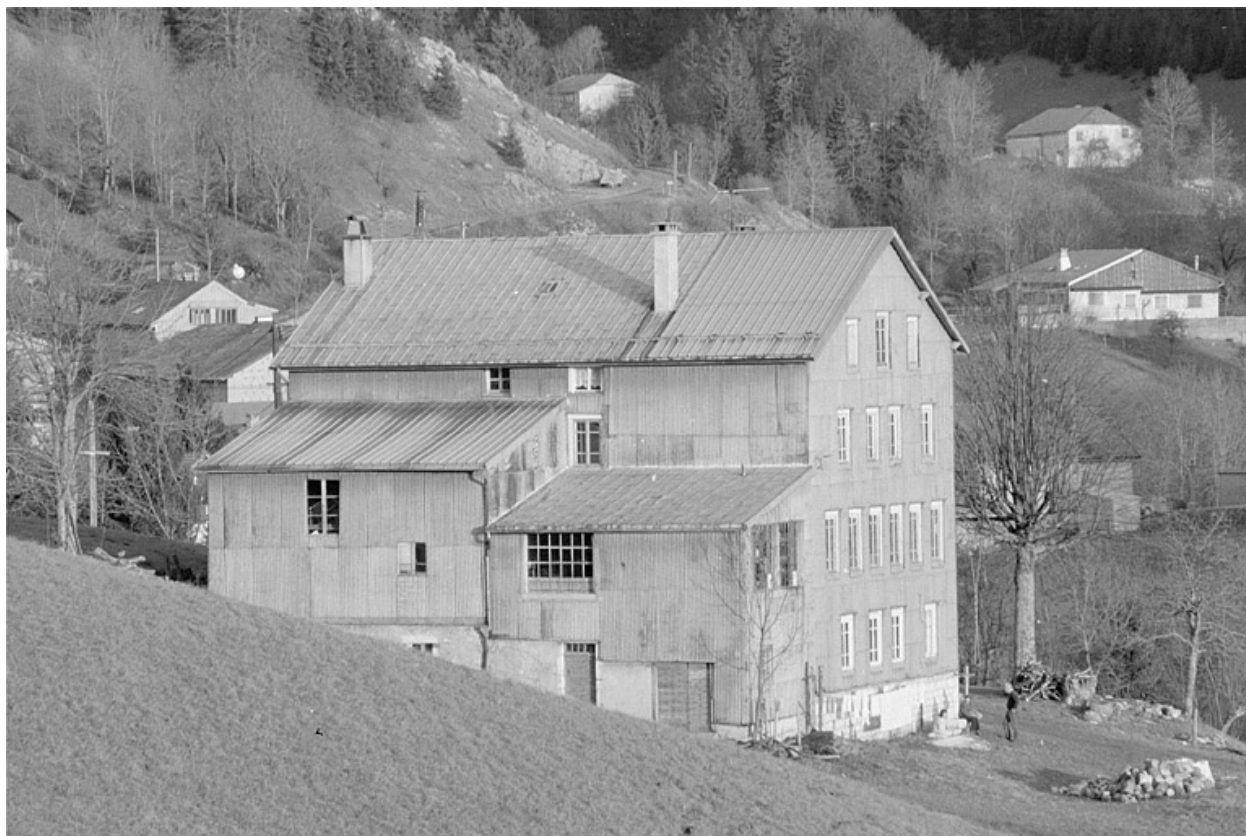
Façades postérieure et latérale droite.
