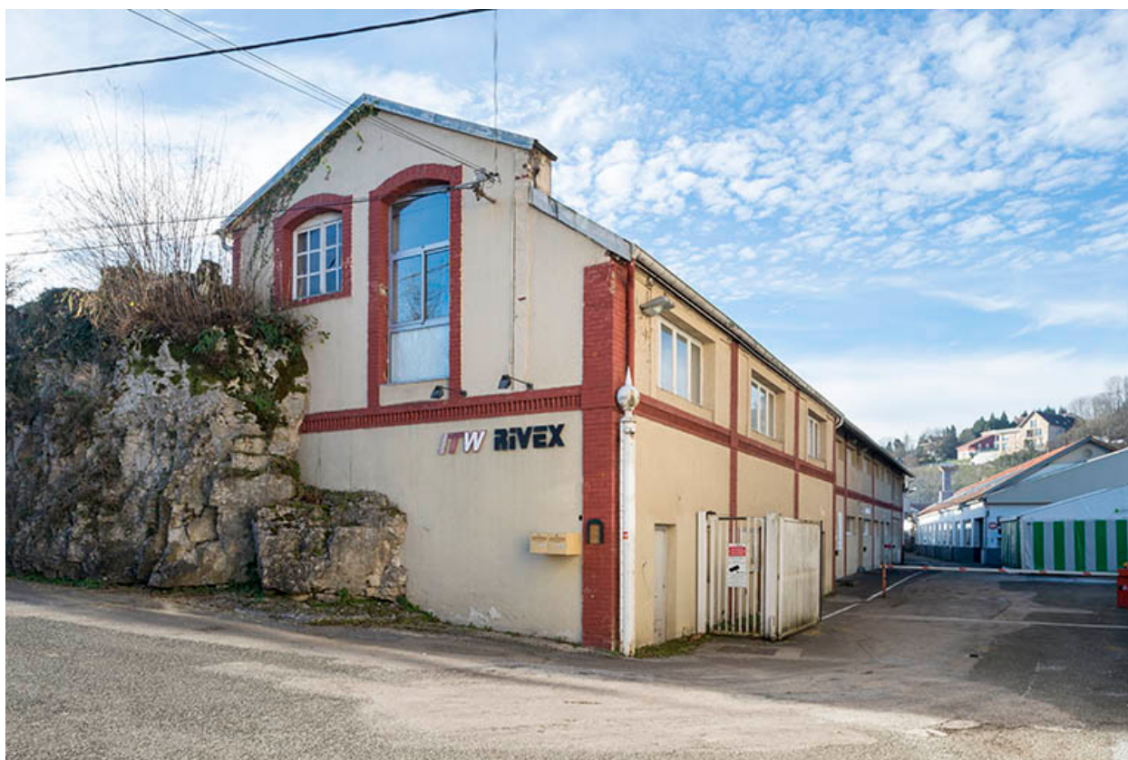
Bâtiment d'accueil de l'ancienne entrée (bureaux).
