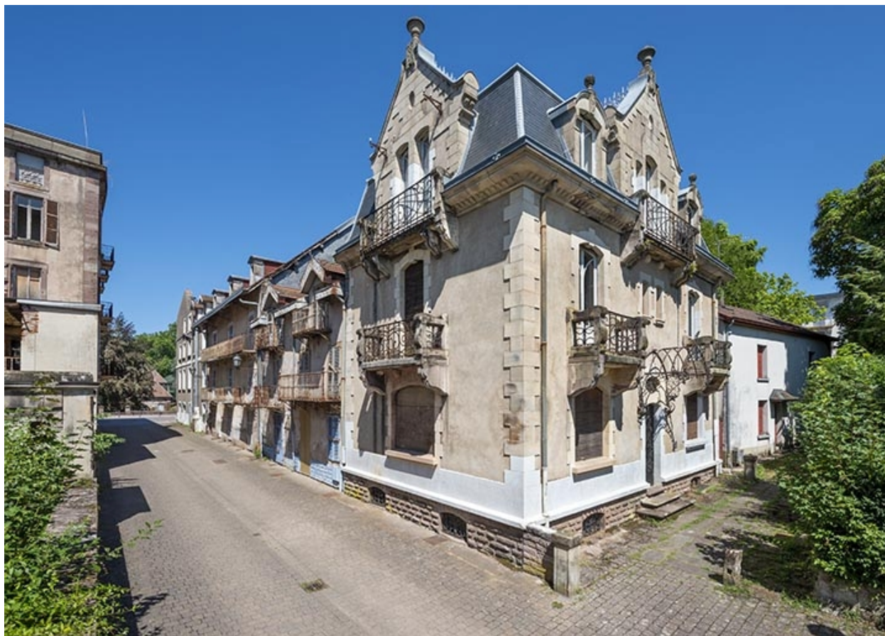
Vue d'ensemble depuis l'allée des Romains.
