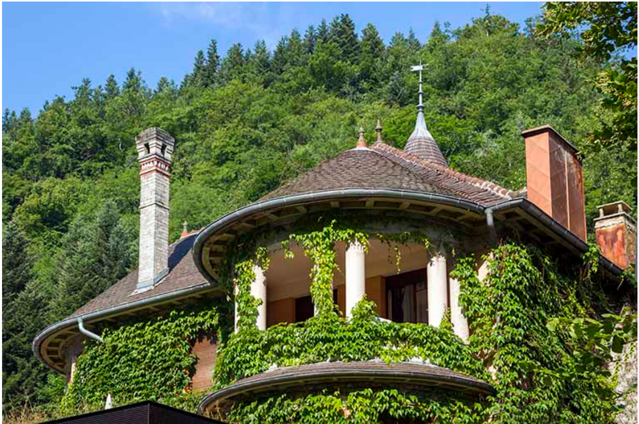
Logement patronal de 1931, façade postérieure : loggia.
