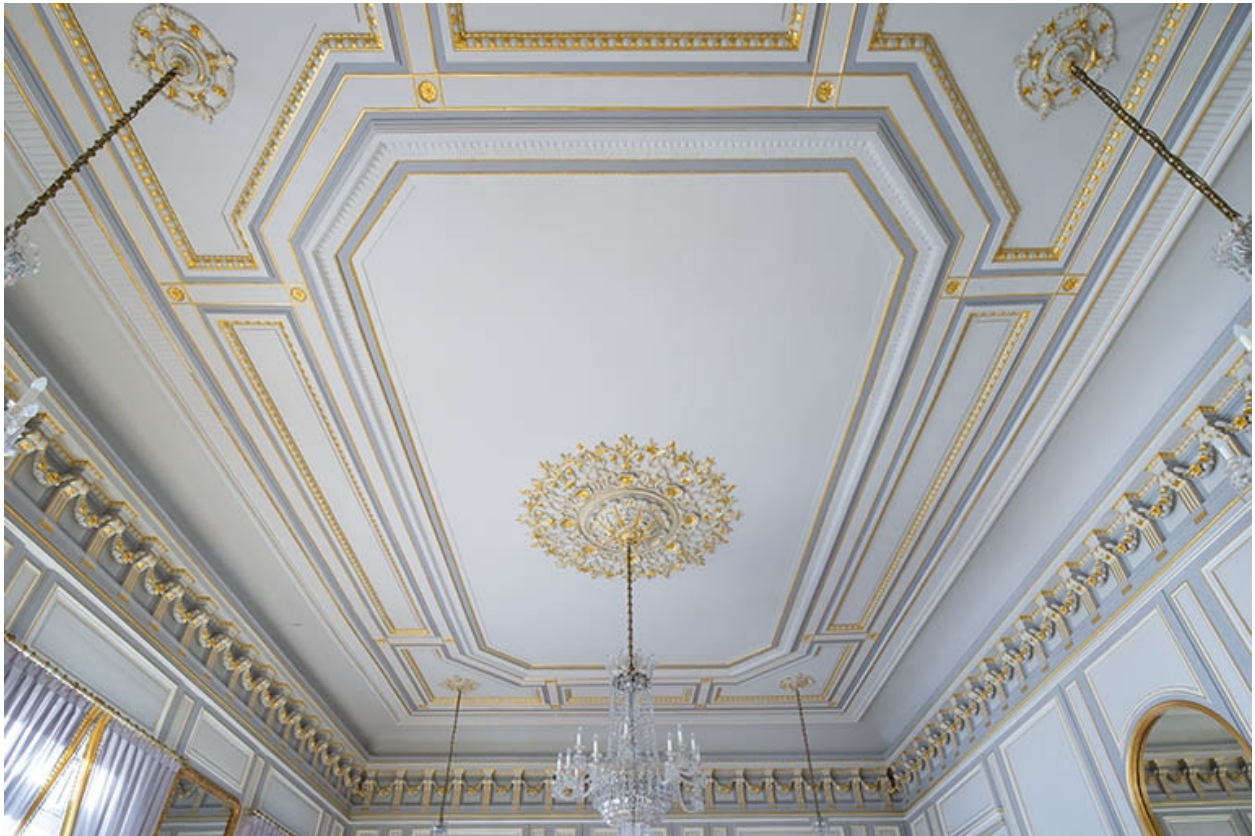
Salle de restaurant, plafond.
