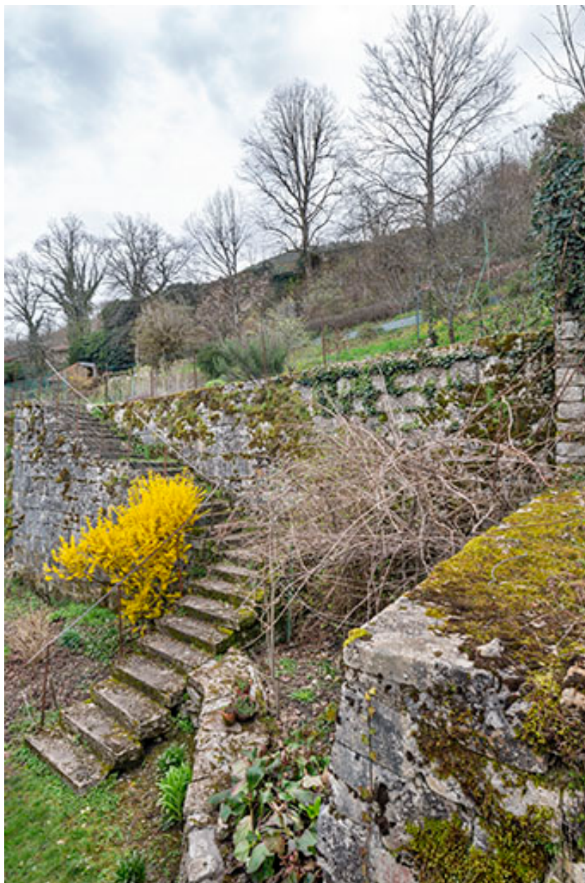
L'escalier d'accès à la première terrasse.
