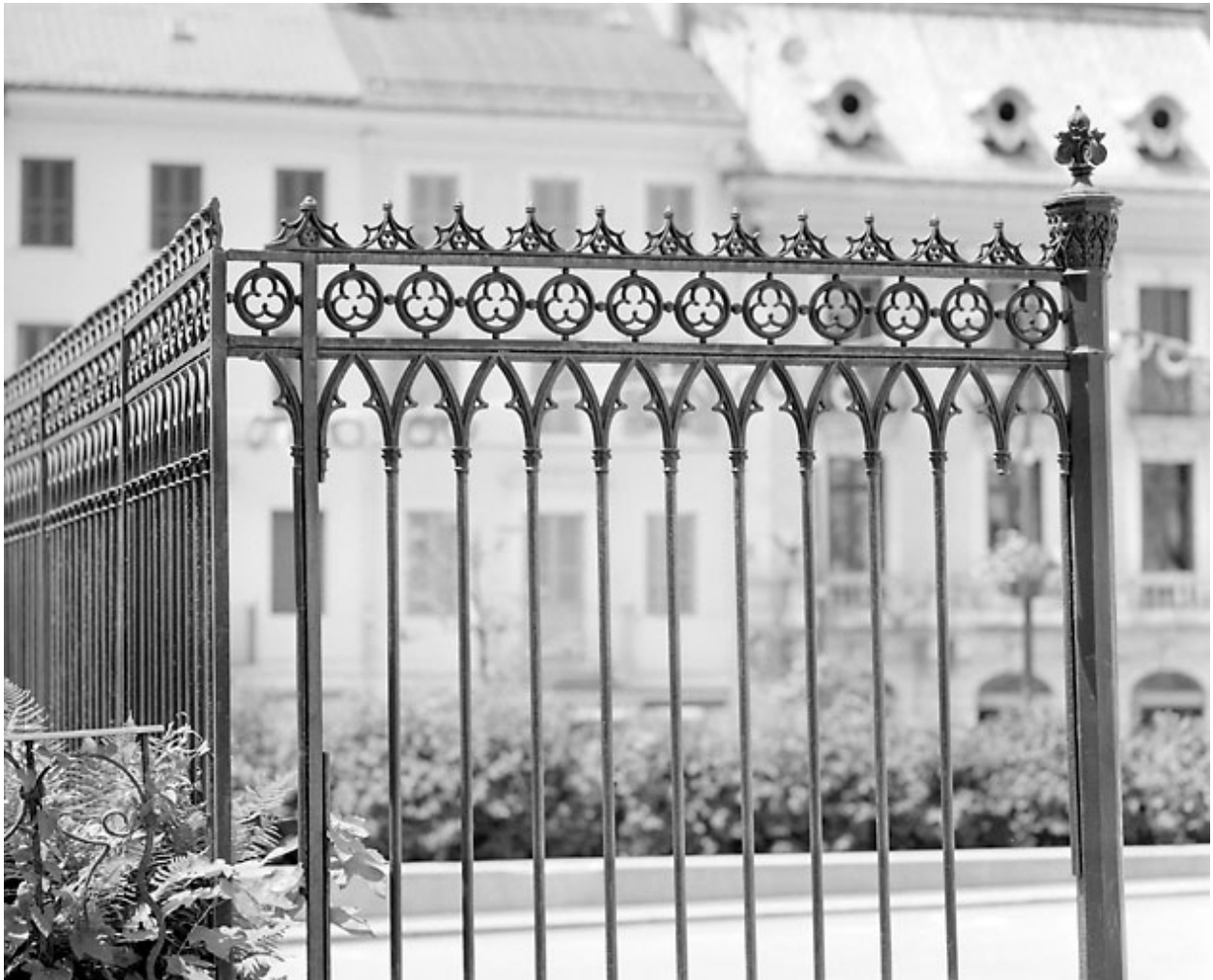
Travée fixe, côté presbytère : partie haute.
