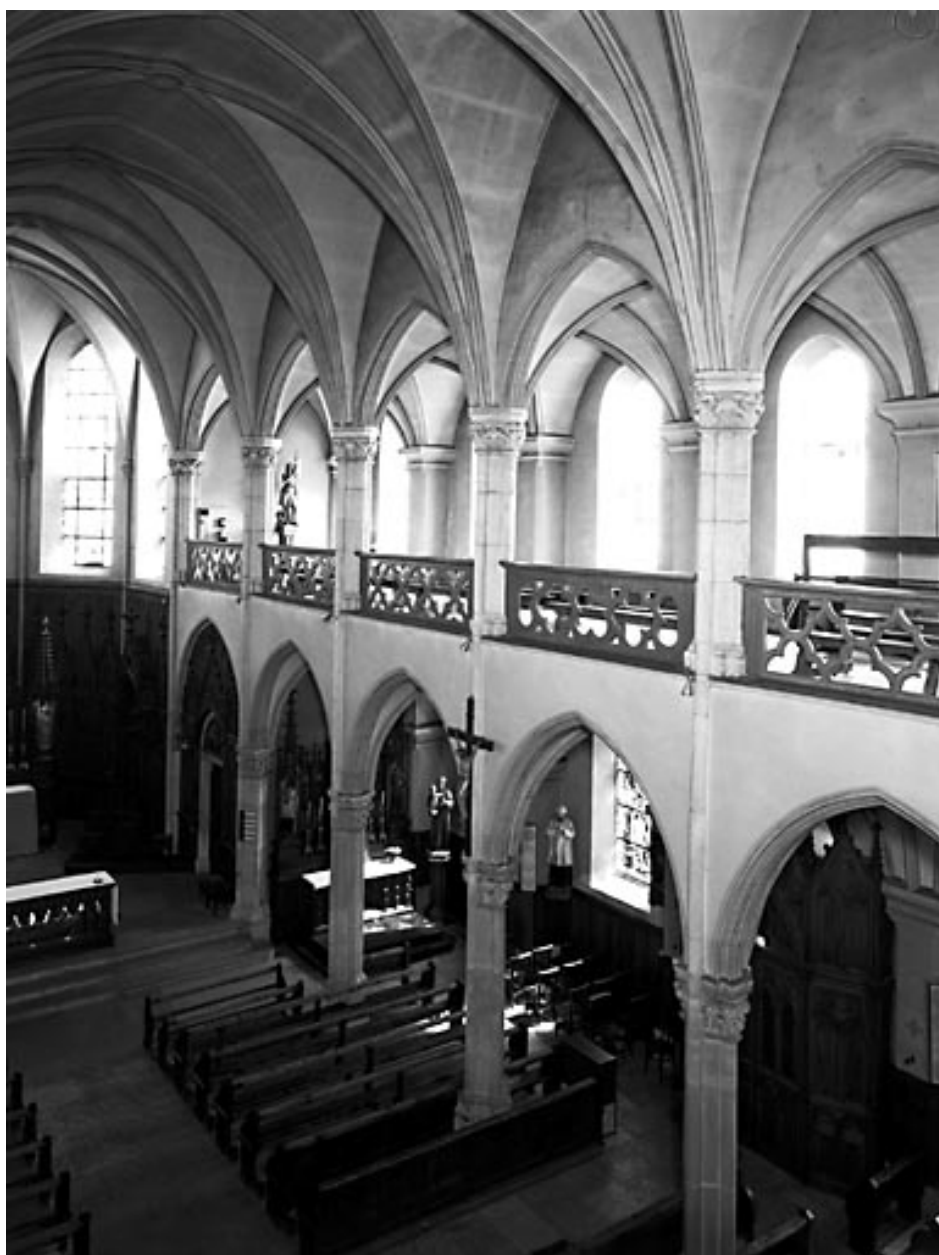
Vue d'ensemble de la nef et du chœur depuis la tribune.
