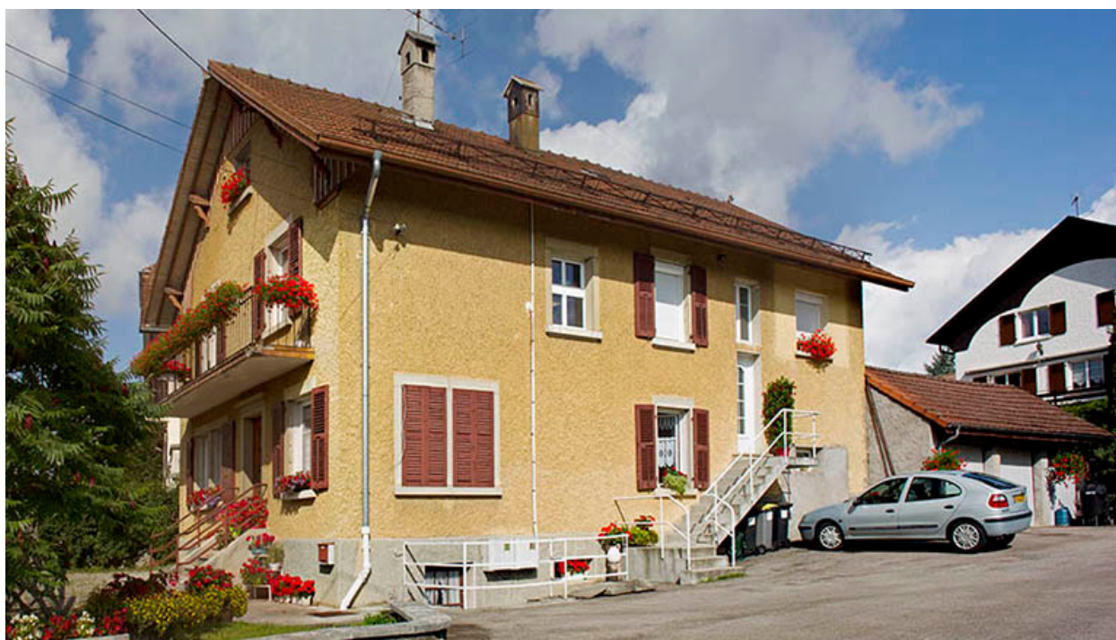
Façades antérieure et latérale droite.
