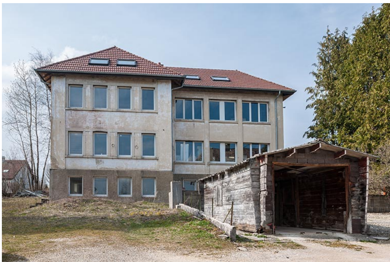
Usine : façade antérieure.
