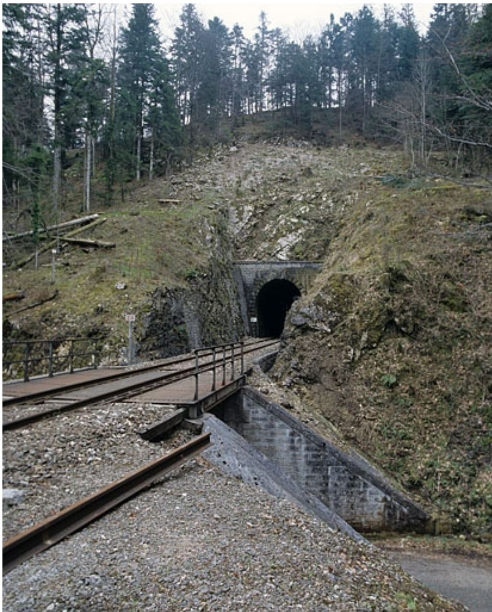
Pont et tunnel, côté Andelot-en-Montagne.
