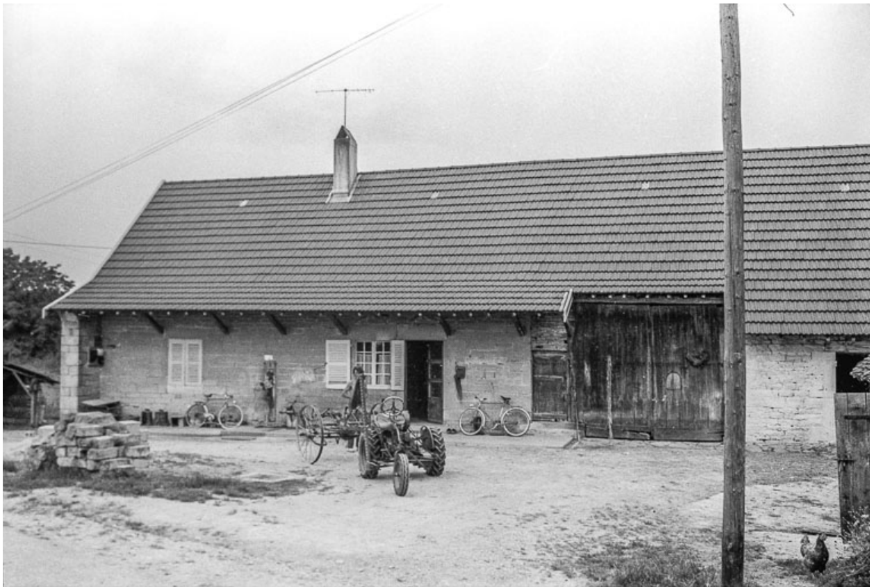
Façades antérieure vue de face.
