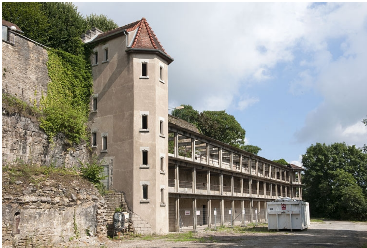
Bâtiment (H), vue rapprochée de la galerie.
