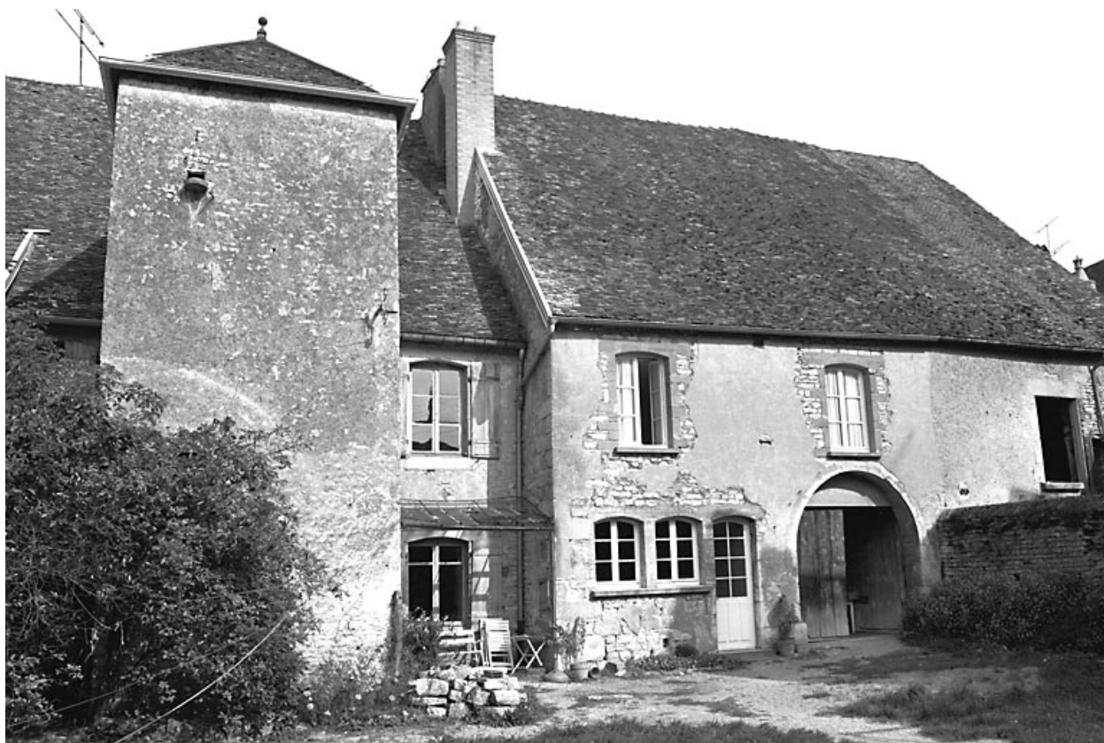
Façade sur cour
