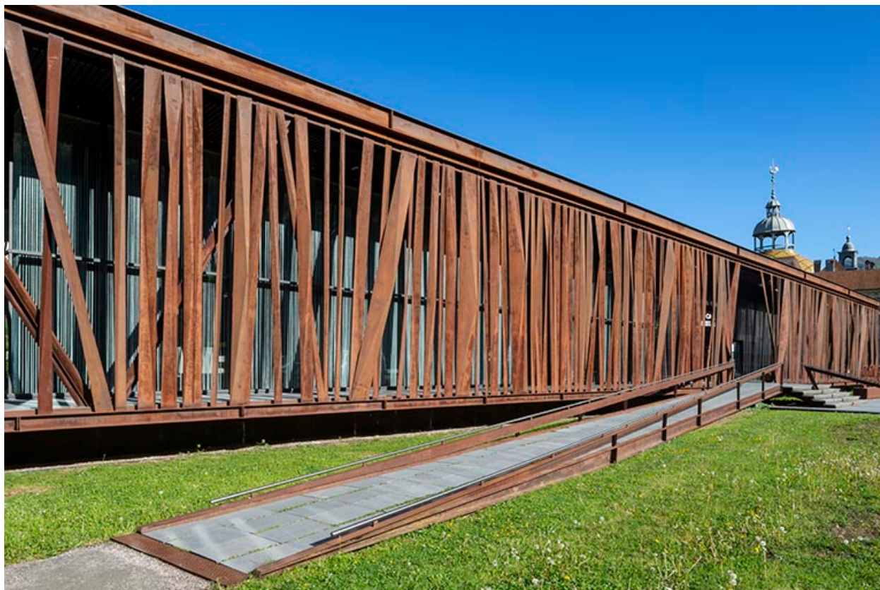
Vue depuis le sud-est.
