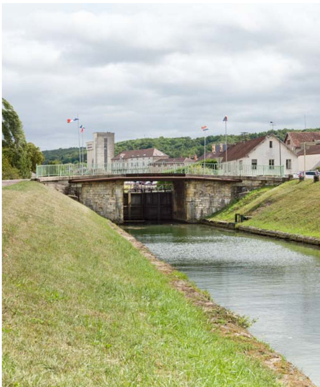
Vue d'ensemble du pont (en 2017).
