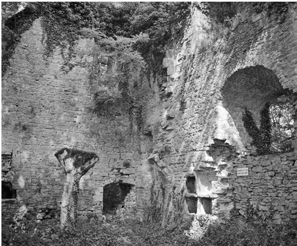
Chapelle du château, vue intérieure.
