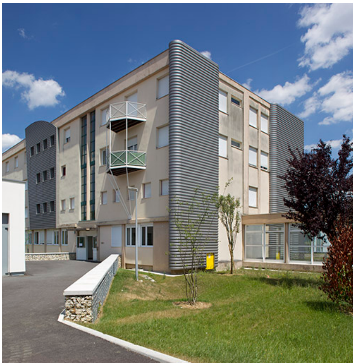
Angle sud-ouest, pignon sud de l'internat.
