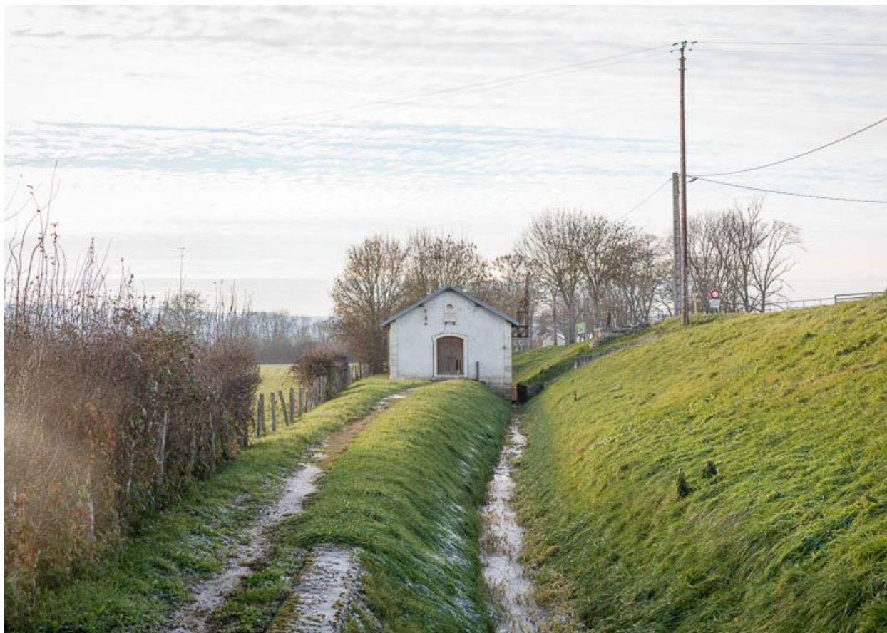
Vue de l'entrée de l'usine.
