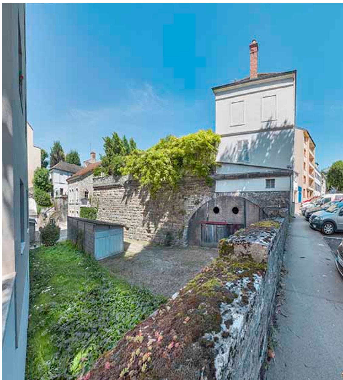
Flanc sud du bastion Saint-Paul.
