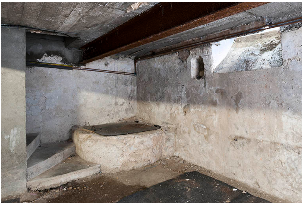
Cave comprenant le puits.
