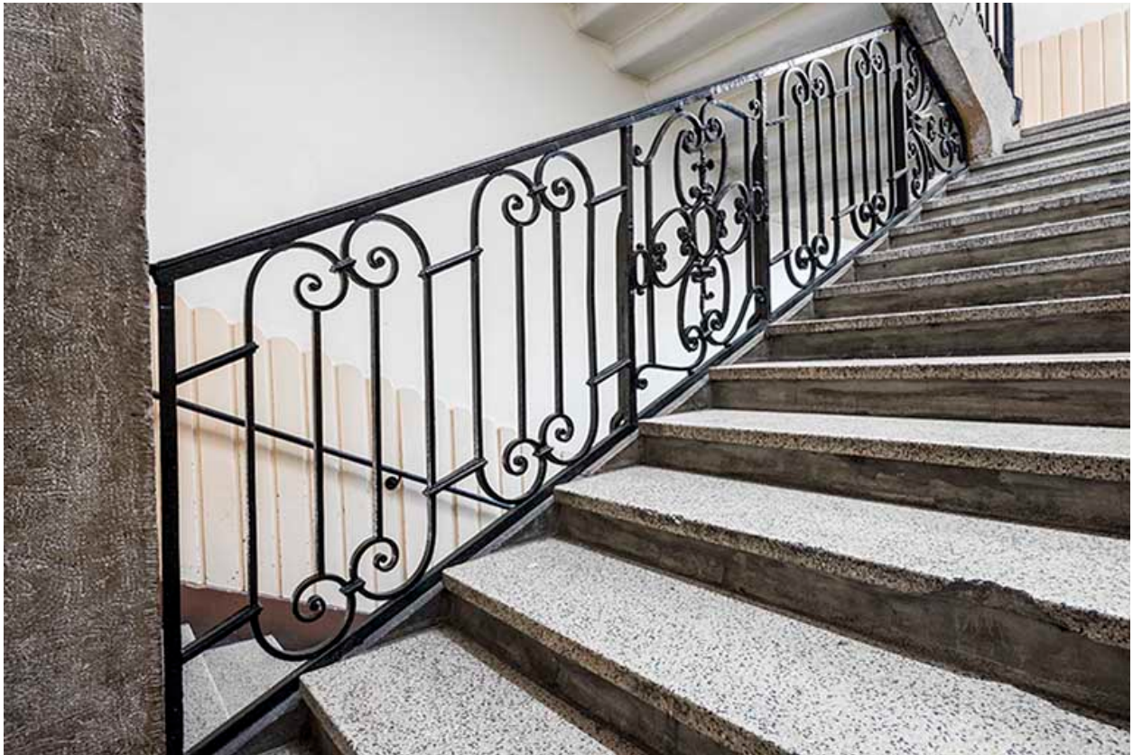
Grand escalier : garde-corps en ferronnerie.
