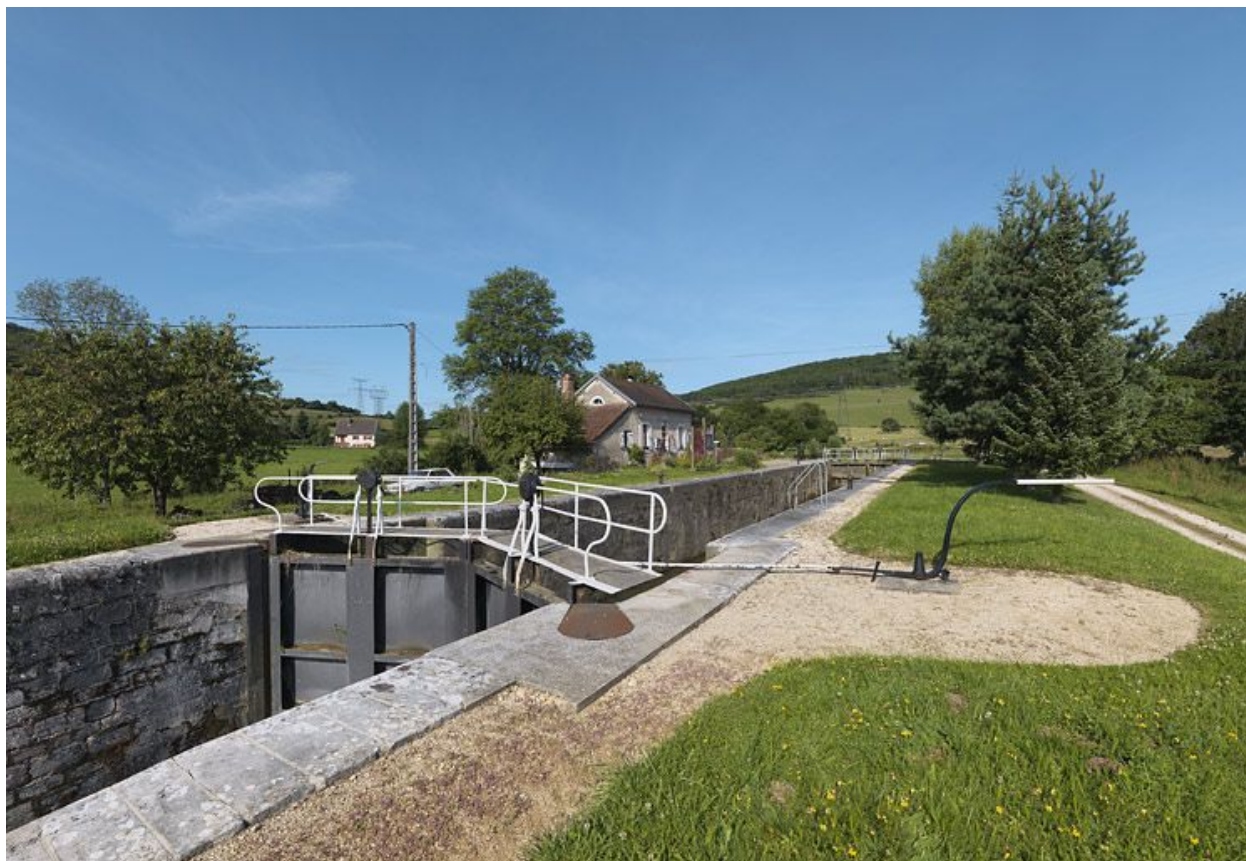
Vue aval du site d'écluse 16.
