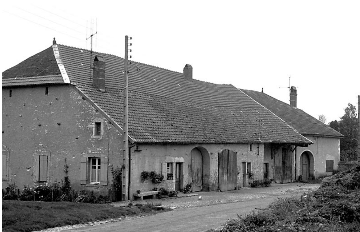
Façades antérieure et latérale gauche.
