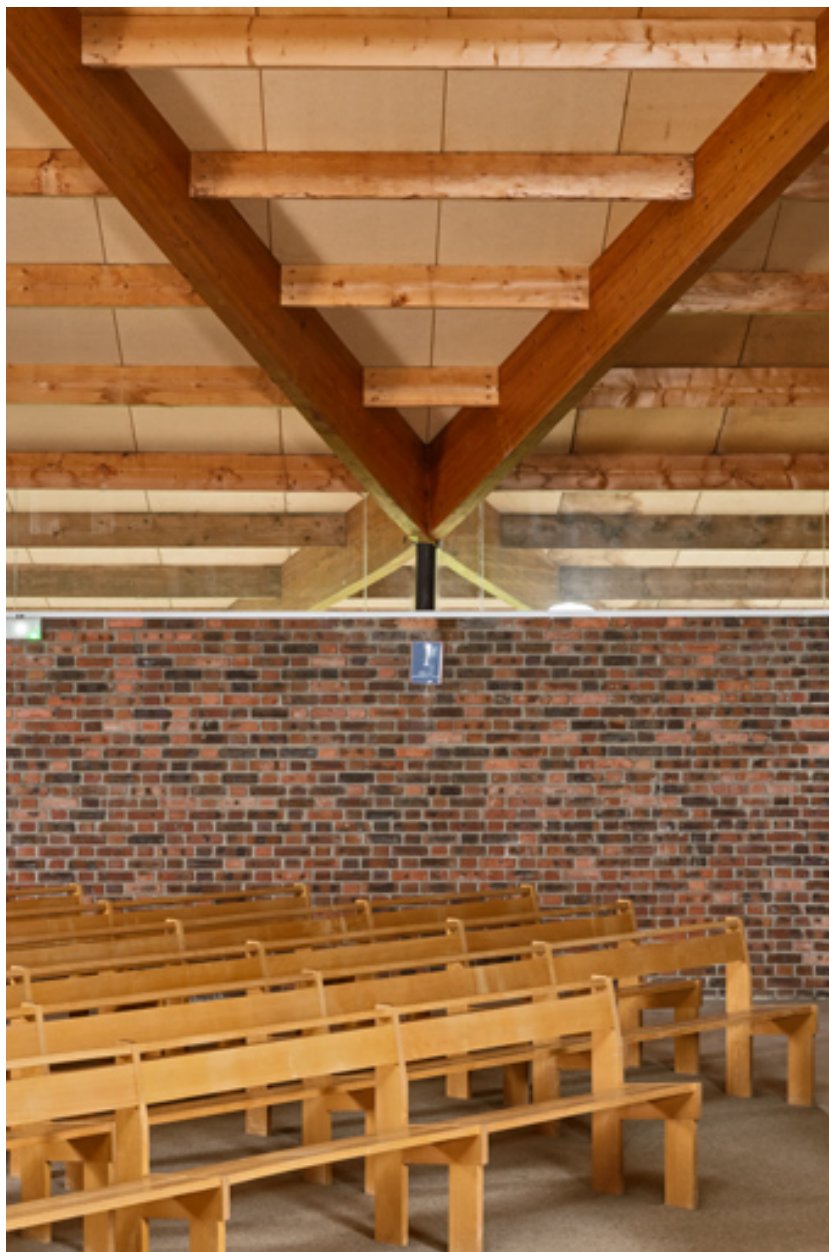
Charpente et pilier métallique intégré dans le mur. Détail.
