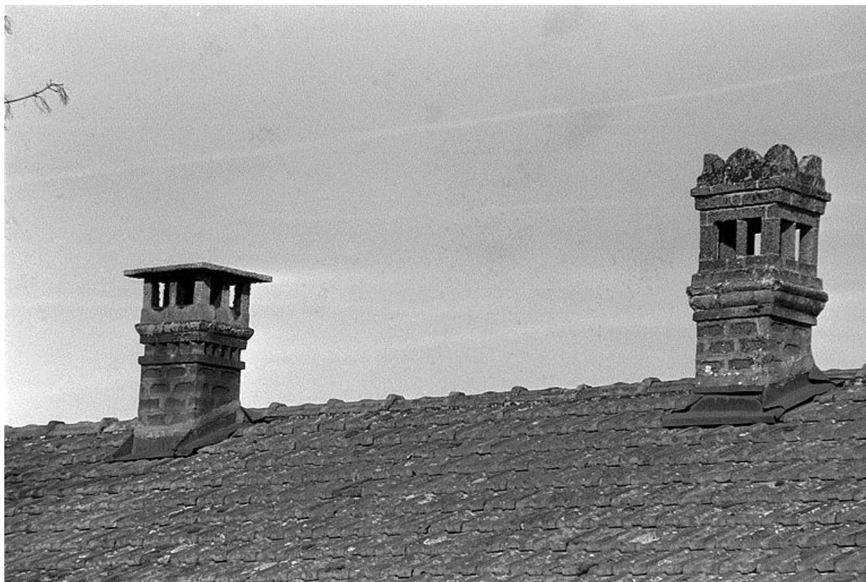
Souches des cheminées du logement.
