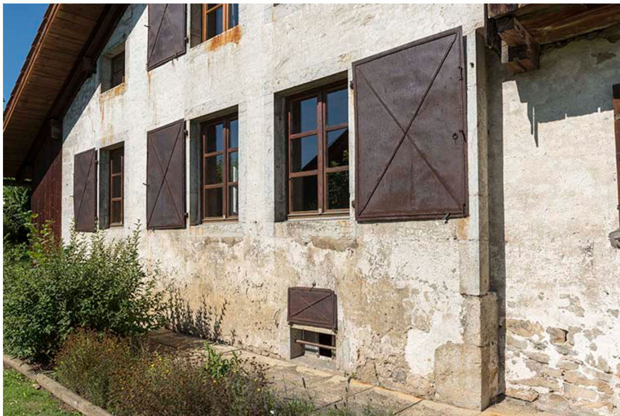
Corps sud-est et ses volets métalliques.
