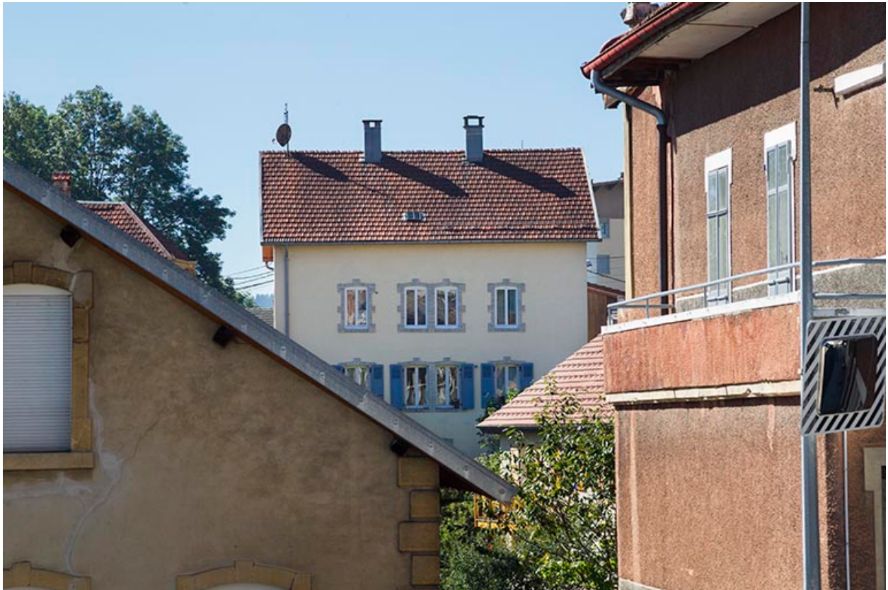
Façade postérieure (vue éloignée).
