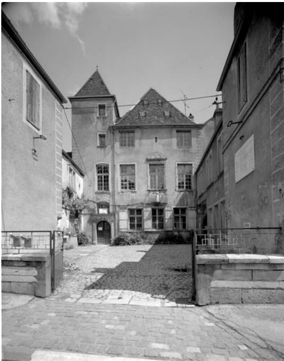
Façade antérieure du corps de bâtiment principal.
