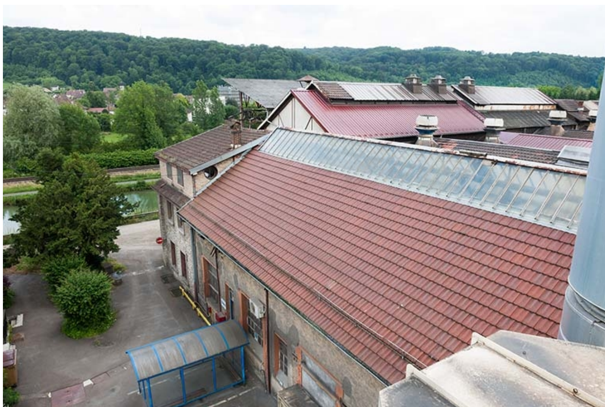
Vue plongeante sur l'ancien atelier de noyautage.
