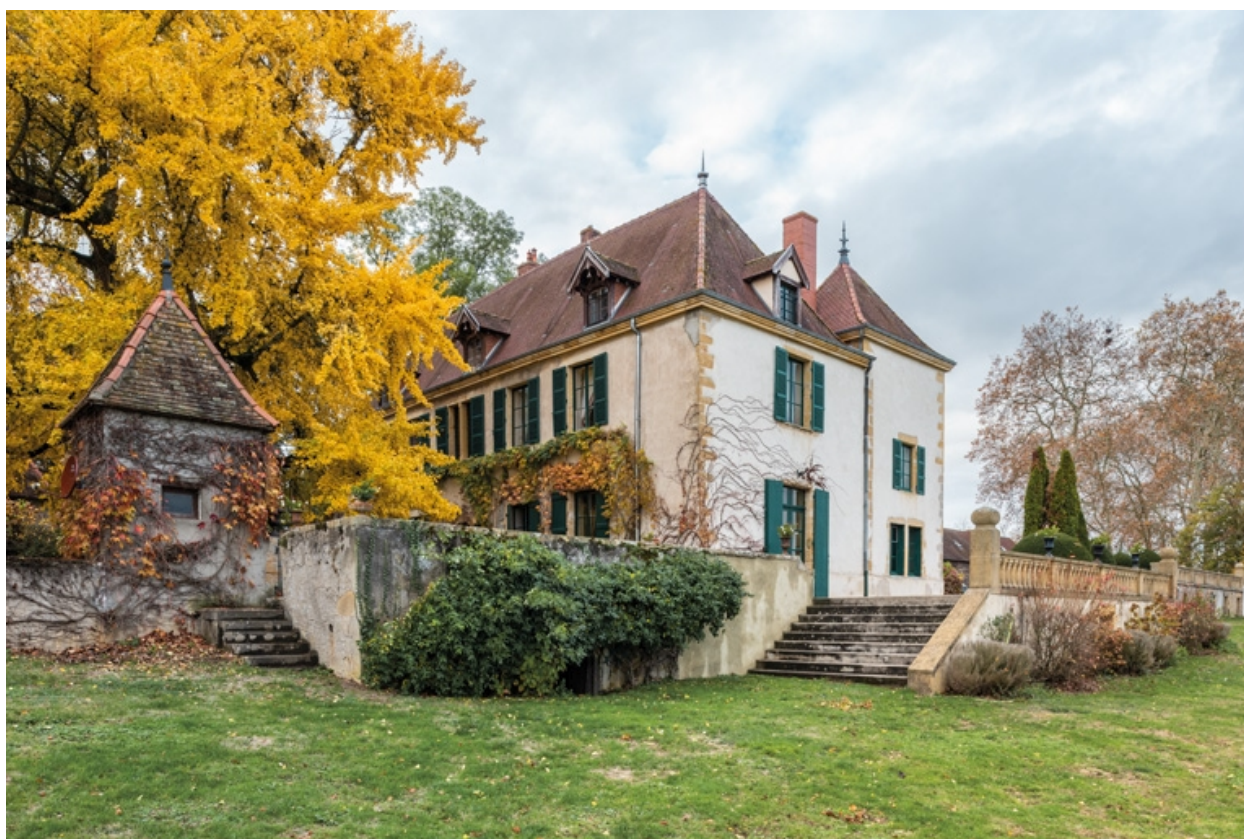
Château : vue de l'est
