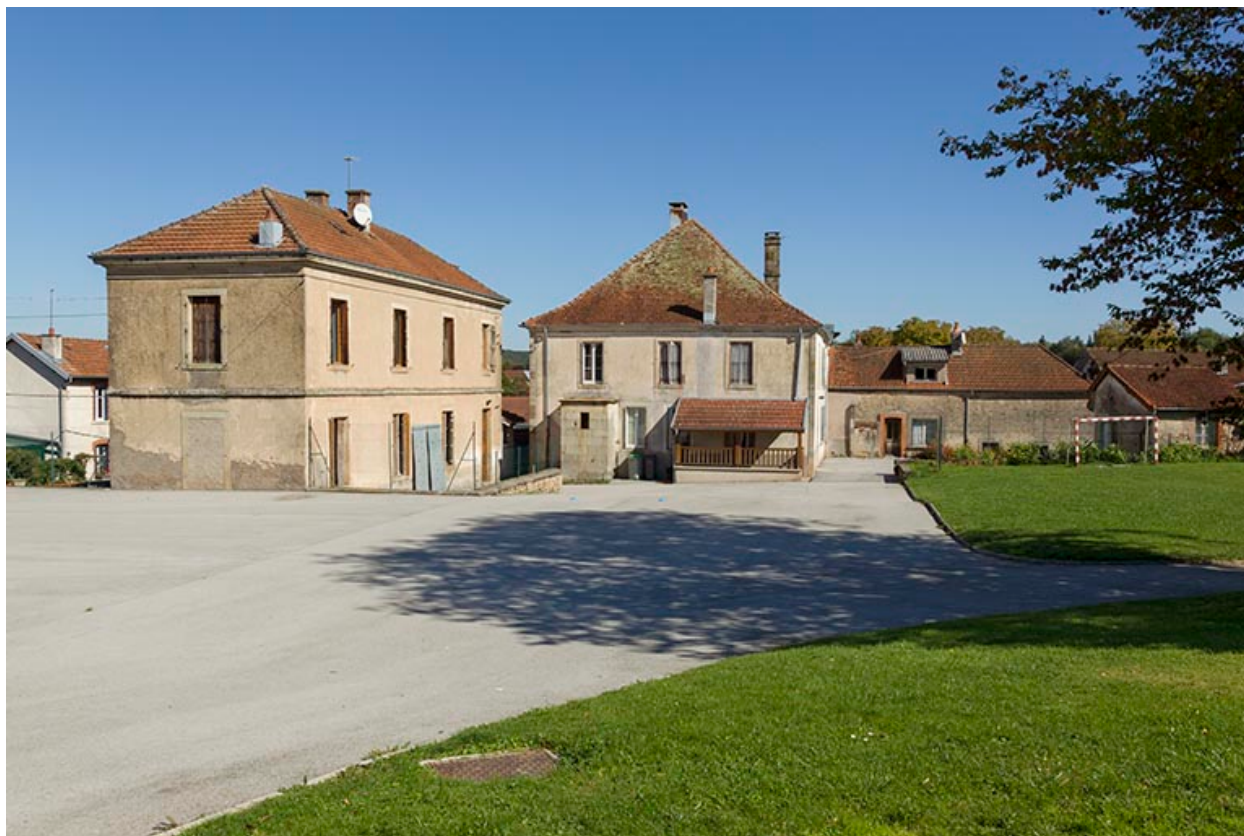
Façades sud et est de l'école.
