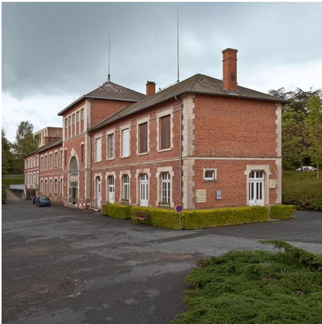
Bâtiment de service.
