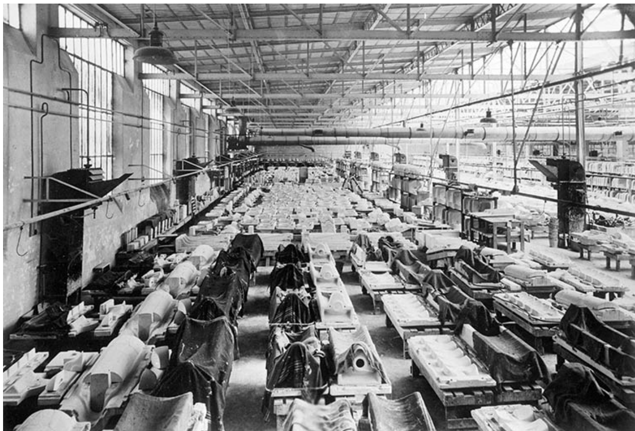
Atelier de coulage.
