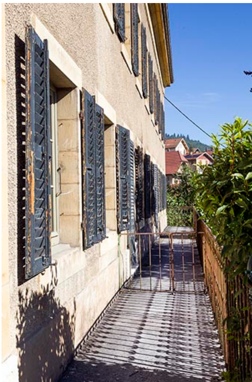
Maison : façade latérale droite, vue en enfilade.
