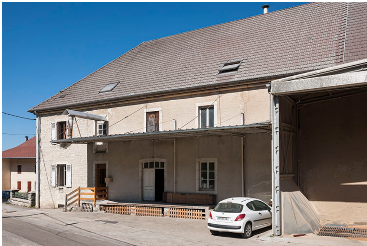
Façade sud-est de la minoterie.
