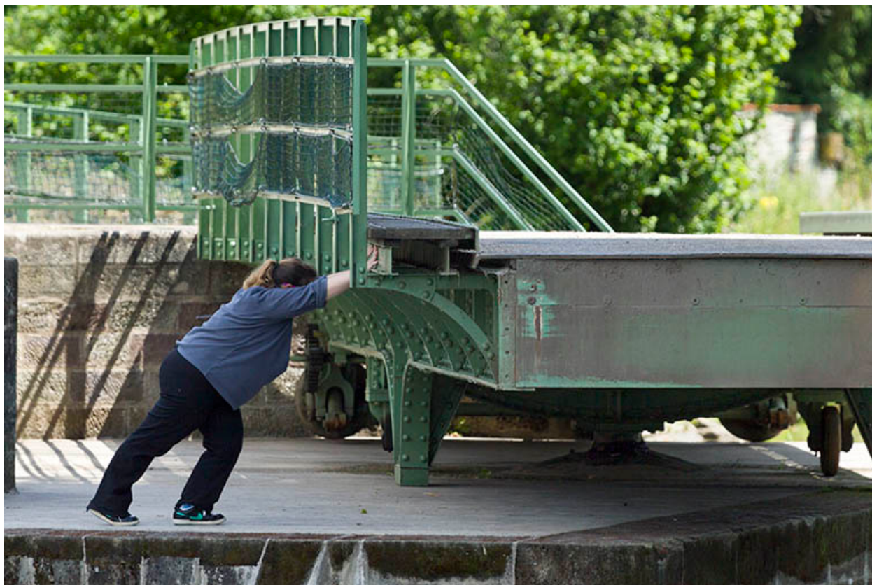
Rotation du pont par poussée manuelle.
