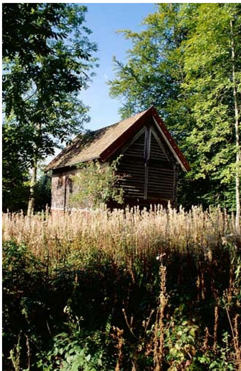
Vue de trois quarts du hangar séchoir.
