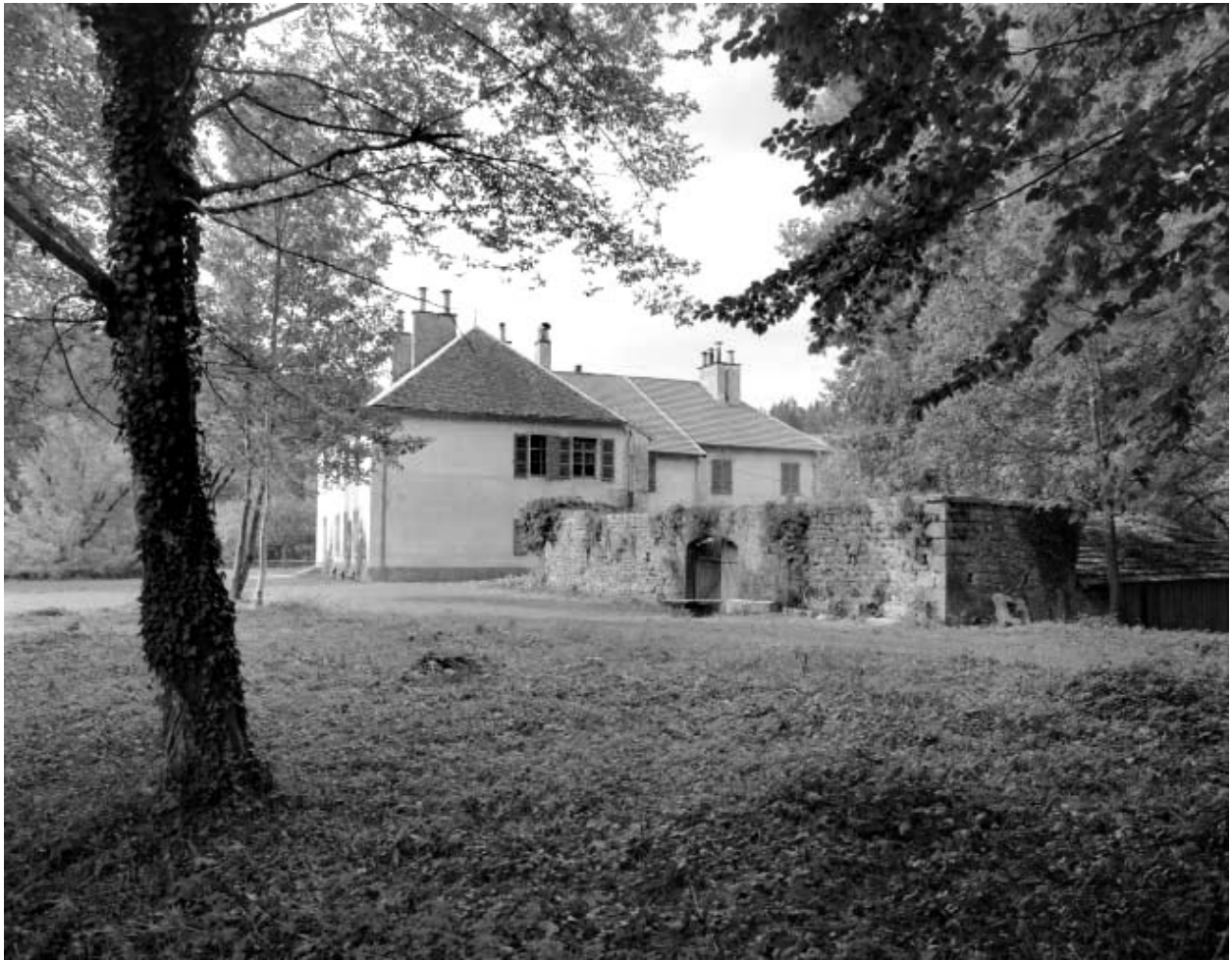
Façade postérieure de l'habitation depuis le parc.
