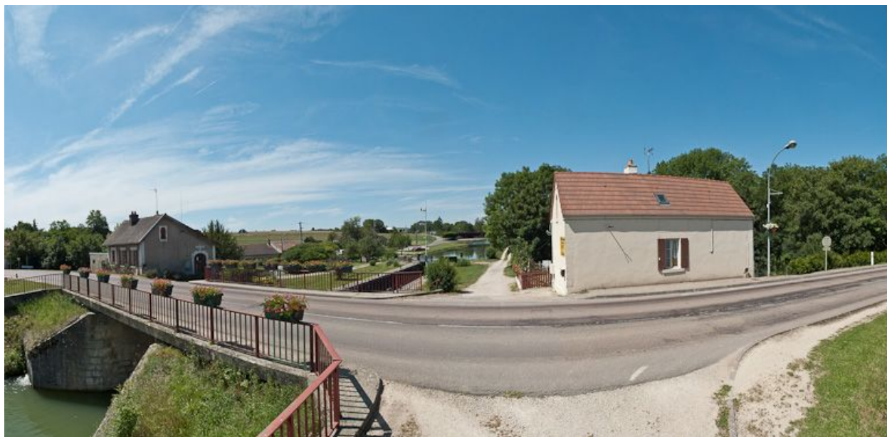
Vue d'ensemble du site d'écluse.
