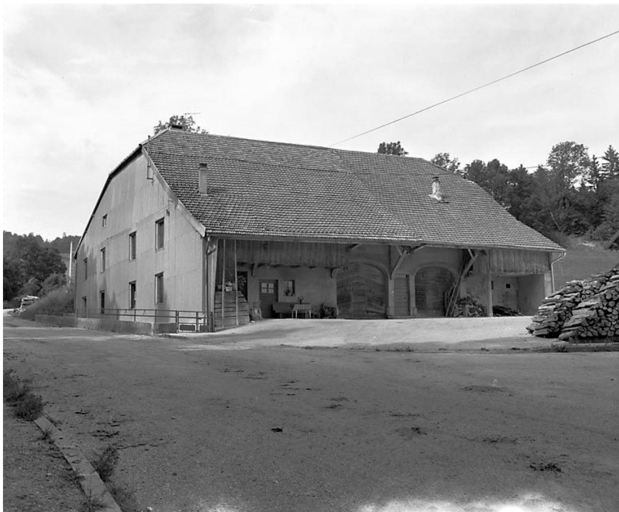
Ferme située chemin des Esseux.
