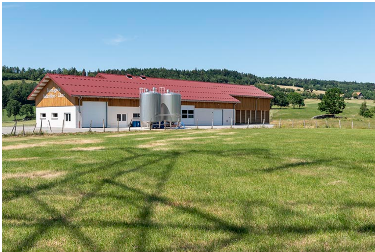
Façades postérieure et latérale droite.
