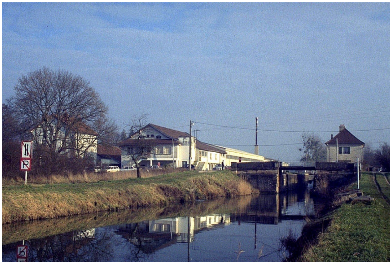
Vue d'ensemble depuis l'ouest, avec le canal.
