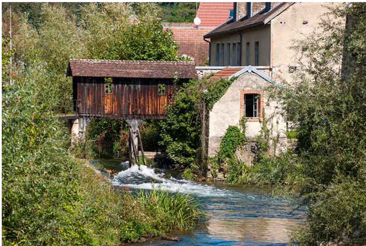
Vestiges du barrage depuis l'aval.
