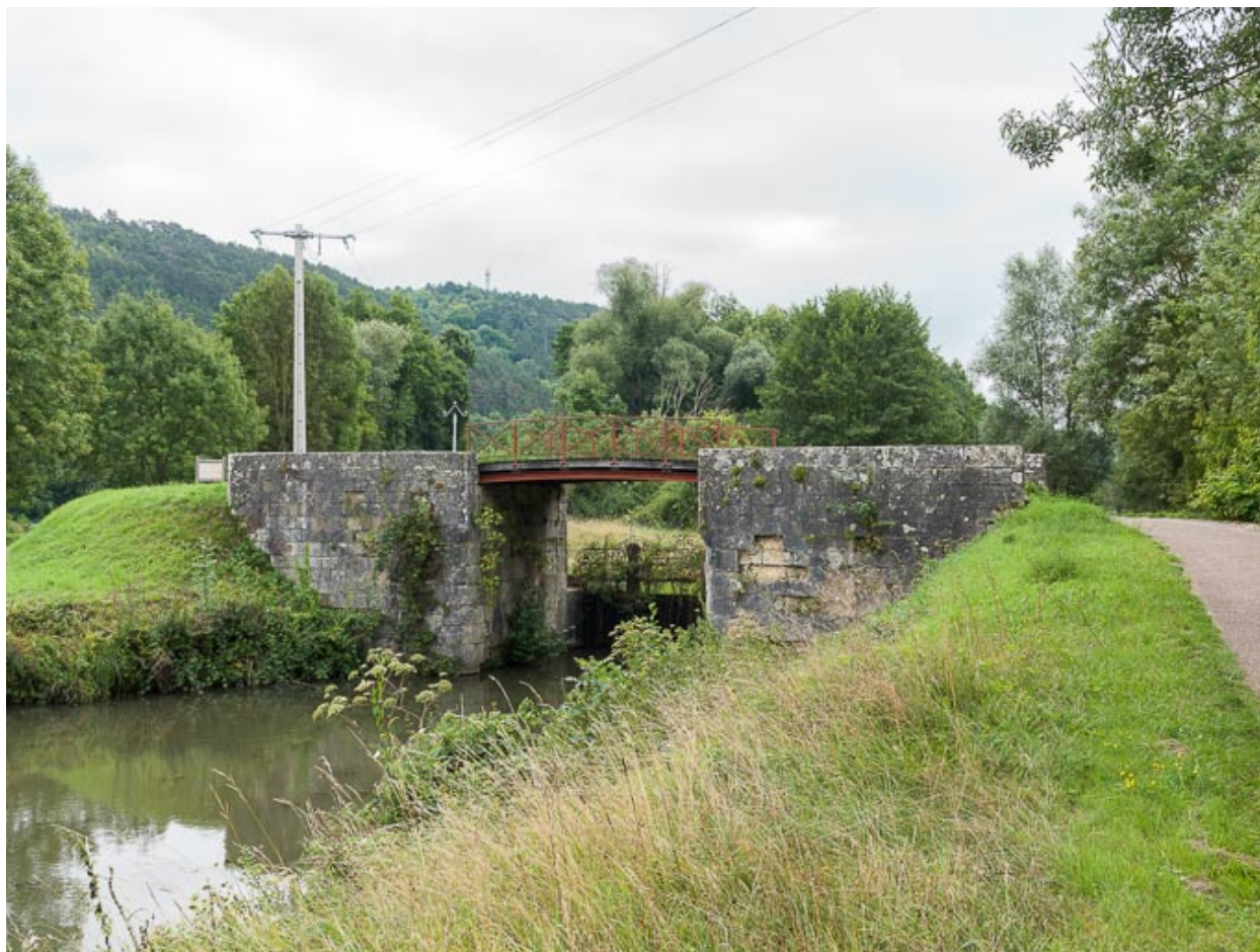
Vue du pont.
