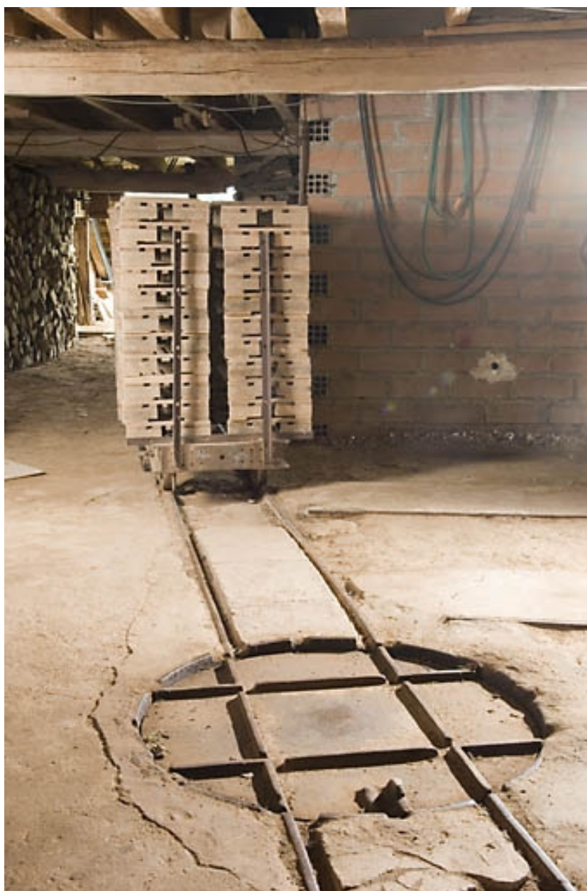
Wagonnet à plateaux sur voie Decauville.
