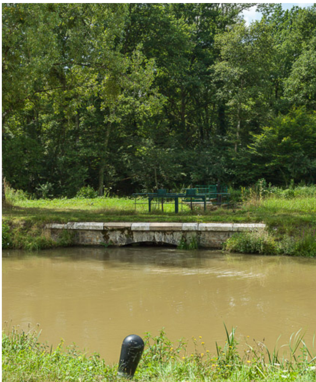
Vue de la prise d'eau.
